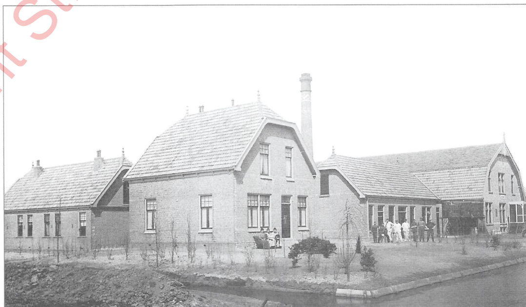
Zuivelfabriek Excelsior met directeurswoning aan de Middenweg bij de spoorwegovergang. Plm. 1915. De directeurswoning staat er nog, Middenweg 333.
