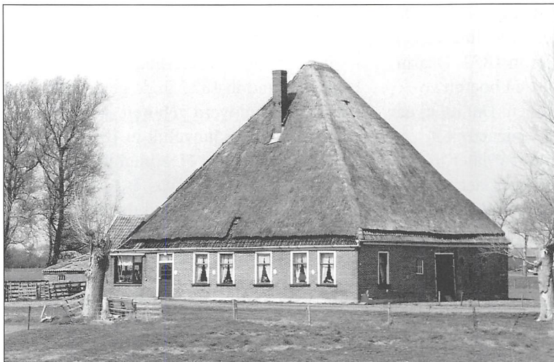
De enkele jaren geleden gesloopte stolpboerderij Groenedijk 9.
