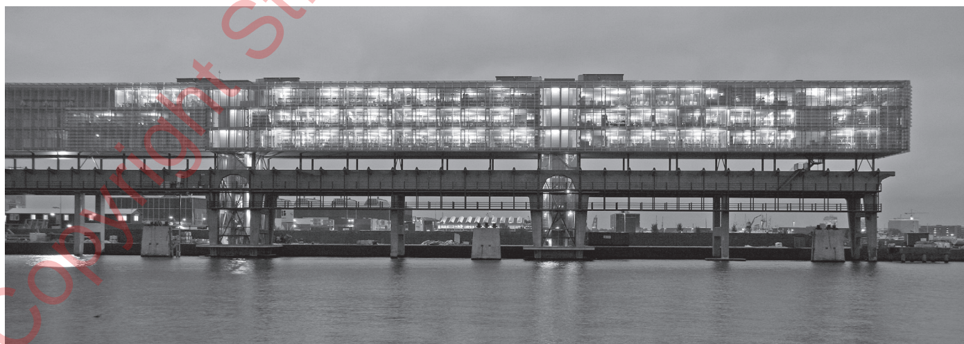
□raanspoor, □□-oever Amsterdam. □roject samen met bouwbedrijf De □ijs te Warmenhuizen. Het □raanspoor is een lichtgewicht werkgebouw van 12.□00vierkante meter. □et drie verdiepingen, boven een betonnen afbouwsteiger uit het glorieuze verleden van de □D□□□□ederlandscheDok en □cheepsbouw□aatschappij□.Het gebouw - 2□0meter lang en 12,□meter breed - □zweefde□ meter boven de dikke betonnen wanden van de onderbouw □200□□.
