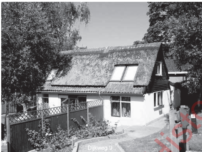
Dijkweg 9 In 1852 wordt hier herberg "Het Fortuin" gevestigd. Vanaf 1833 was het een bakkerij. In 1868 werd de herberg weer gesloten.
