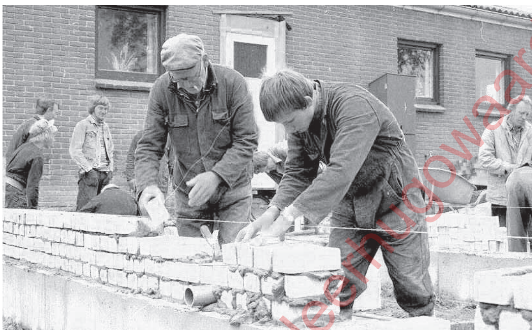
Het metselen van de fundering
