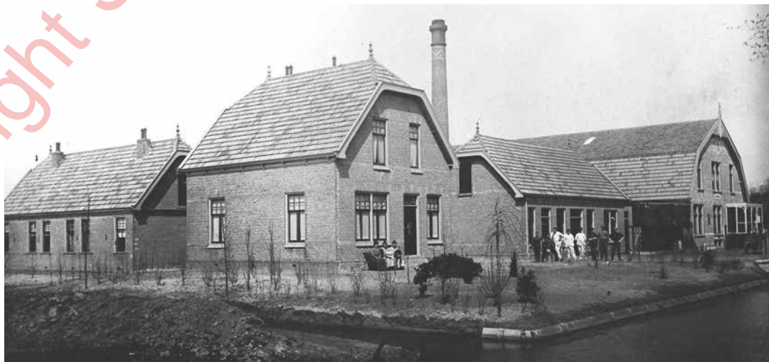
Excelsior in 1913 aan de Middenweg. Links de directeurswoning. Dit huis staat er nog.
