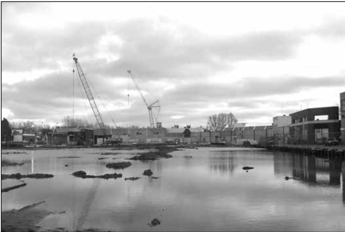
De aanleg van parkeerplaatsen aan de kant van AH, december 2008
