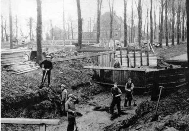
Door het bouwen van schutsluizen en kolken veranderde Heerhugowaard van een rijpolder in een vaarpolder. Op de foto werkzaamheden rond 1928 aan een kolk in de Middenweg. Op de achtergrond boerderij d'Olifant, Middenweg 55.
