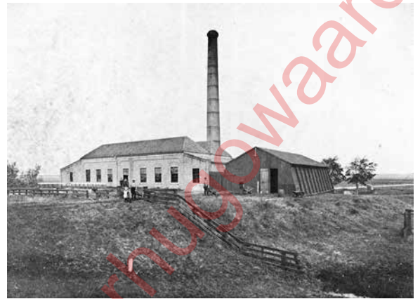
Het in 1877 gebouwde stoomgemaal van de polder Heerhugowaard, gezien vanaf de Huygendijk. De voorzijde van het pand heeft nog in het midden een toegangsdeur. In het linkerdeel bevindt zich de machinekamer met de stoommachines, in het rechterdeel is het ketelhuis. Rechts naast het gemaal de houten keet die diende voor de opslag van steenkool. (foto uit 1929 van Delemarre, Alkmaar).
