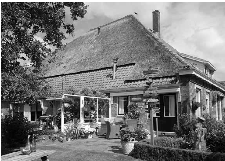
De zuidgevel met de gele handgevormde steentjes en links de deur naar "De Stal"
