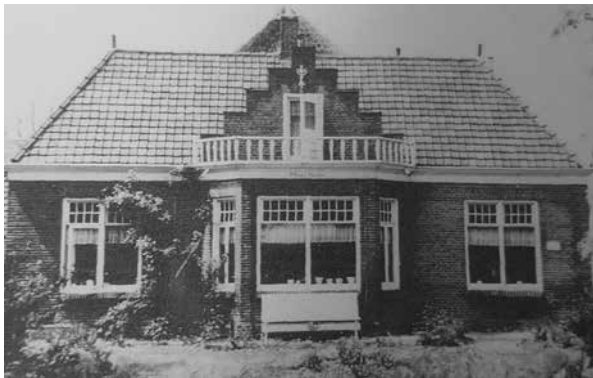
Mina's Hoeve met balkon, gesloopt in 1977. Achter het huis zie je nog juist de punt van de boerderij. Die werd toen verbouwd tot woonhuis.
